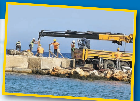
Phaselis'te sürdürülen restorasyon ve çevre düzenleme çalışmaları antik kenti şantiyeye çevirdi
